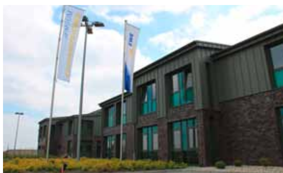
Speicheranlage der EWE GASSPEICHER GmbH in Jemgum.
