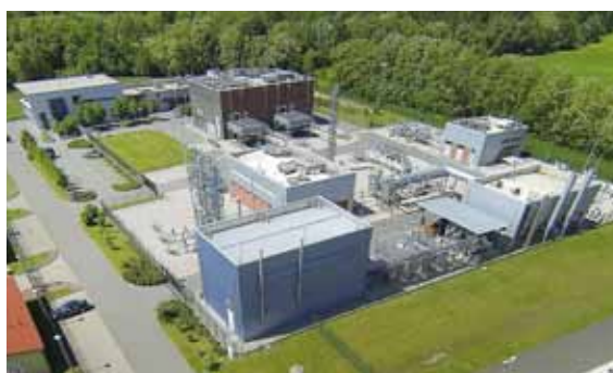
Speicheranlage der EWE GASSPEICHER GmbH in Rüdersdorf.
