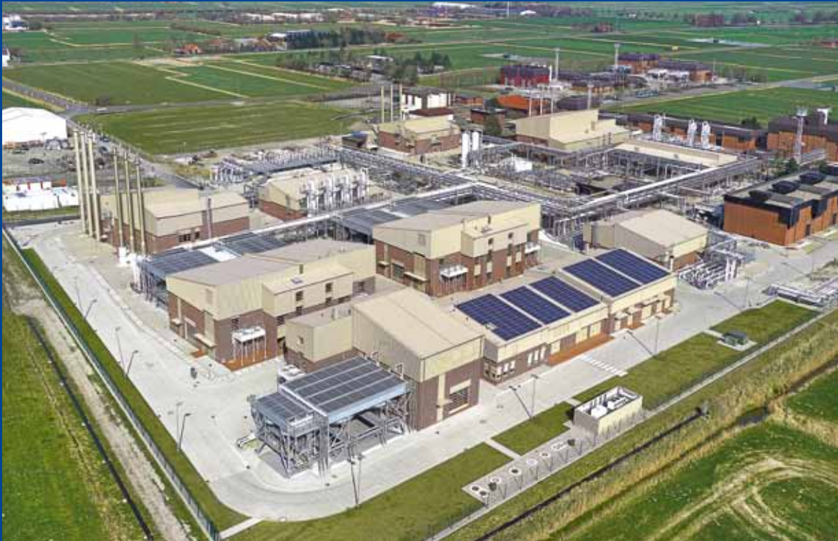
Überirdischer Teil der EWE-Speicheranlage in Nüttormoor.
