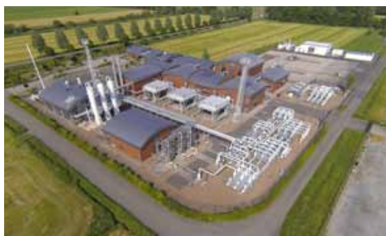
Speicheranlage der EWE GASSPEICHER GmbH in Huntorf.
